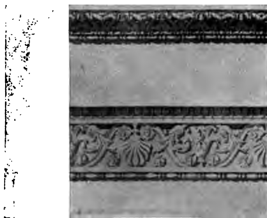
102. Architrav vom Tempel des Castor in Rom.
